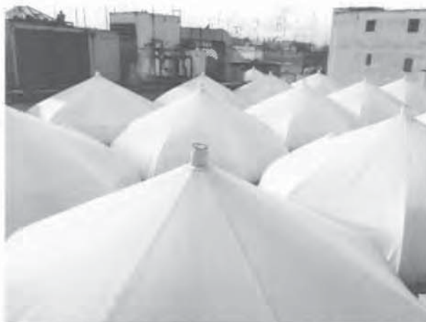
Figura 14: Copertura con struttura portante in acciaio
