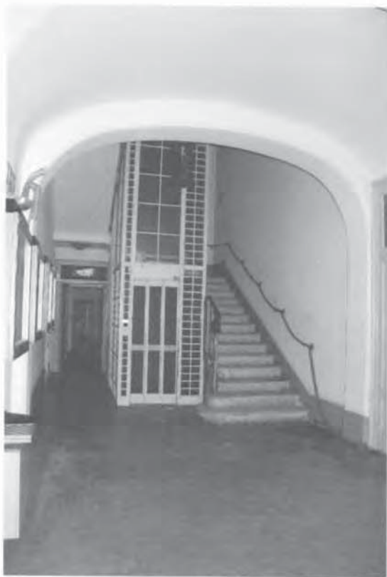
Figura 17: Vano scala e ascensore
